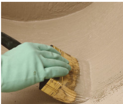
Terasz vízszigetelésének felhordása ecsettel
