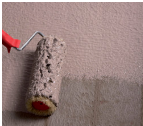
Részletek vízszigetelése hengerrel
