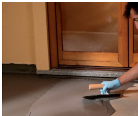
Terasz vízszigetelésének felhordása simítóval
