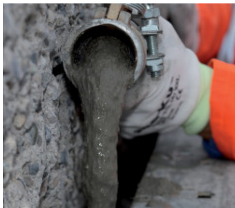
Mapegrout Colabile GF alkalmazása
