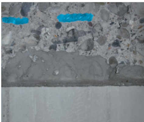
Mapegrout Colabile GF a zsályzat elbontása után
