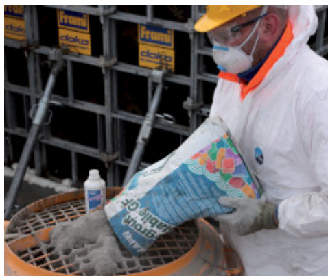
Mapegrout Colabile GF elkészítése Mapecure SRA hozzáadásával
