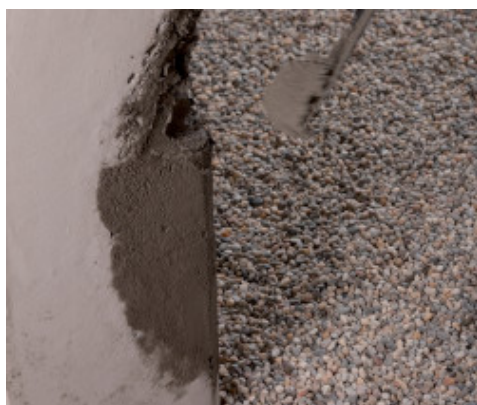
A MapegROUT LM 2K felhordása simítóval
