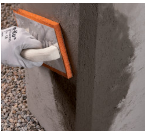
A MapegROUT LM 2K simítása
