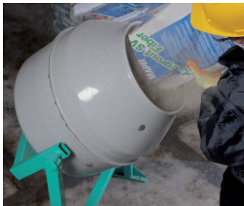
Mapegrout SV Fiber keverék elkészítése
