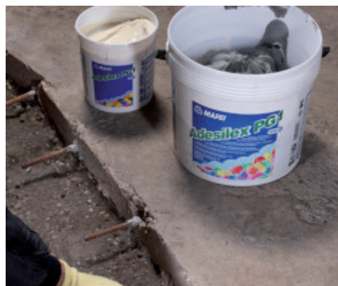
Megerősítő betonacélok rögzítése kitűskésítéshez Adesilex PG1 -gyel
