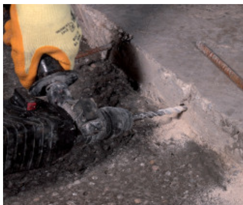
Lyukak elkészítése a megerősítő rudak behelyezéséhez (kitűskésítés)
