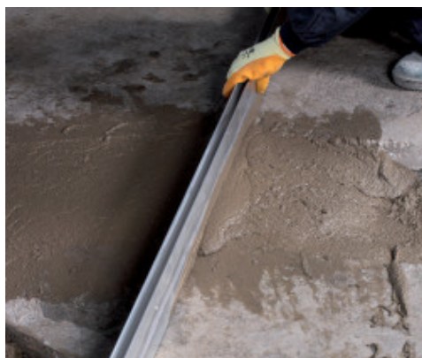
Mapegrout SV Fiber lehúzása egyenes léccel
