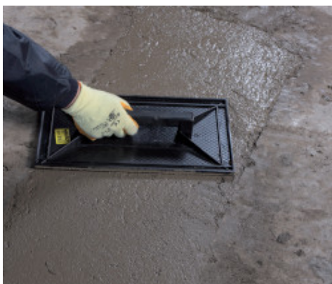
Mapegrout SV Fiber ledöngölése
