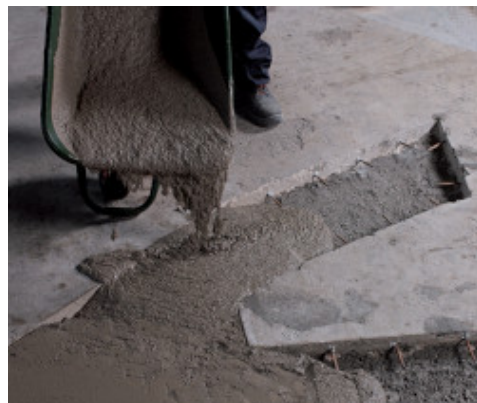
Mapegrout SV Fiber bedolgozása javítás alatt levő területre
