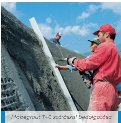
Mapegrout T40 felületképzése
