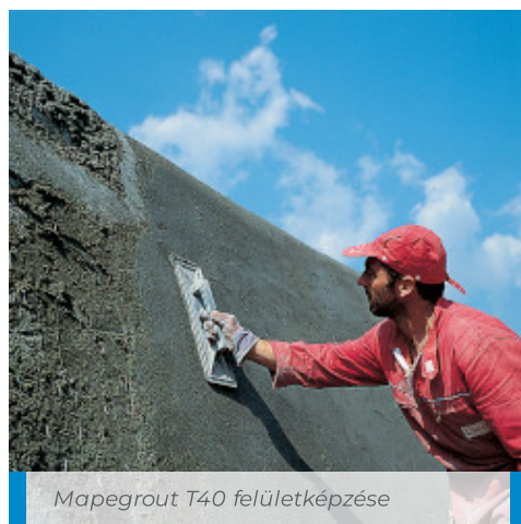
Mapegrout T40 szórással bedolgozása
