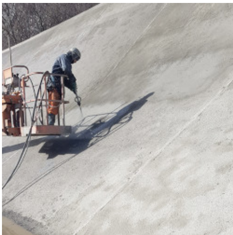
Planiseal 88 felhordása simítóval
