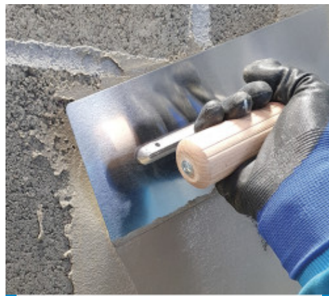
Planiseal 88 felhordása simítóval
