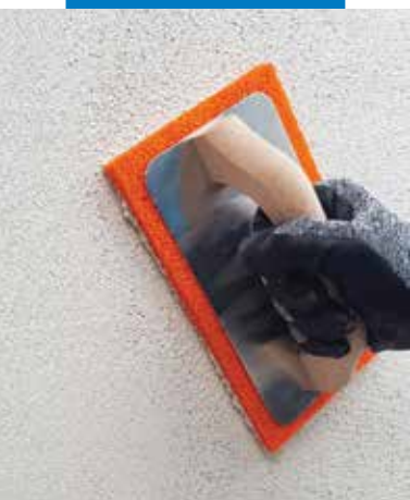
PoroMap Finitura Granello felületképzése szivacsimitóval
