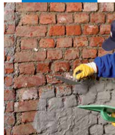
PoroMap Rinzafo Plus bedolgozása simítóval
