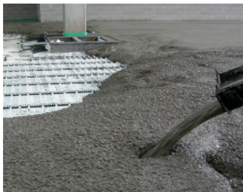
Beton bedolgozása Mapefibre NS18 hozzáadásával a plasztikus zsugorodás ellensúlyozására
