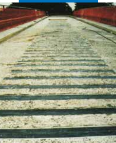
Carboplate lemezekkel megerősített hídlemez
