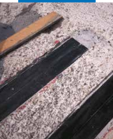
A földembe mart mélyedésekbe ragasztott Carboplate lemezek
