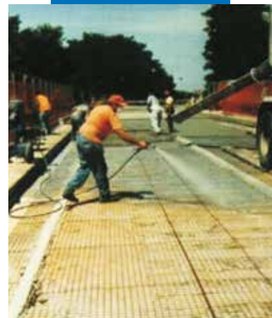
Epoxi alapozó bedolgozása
