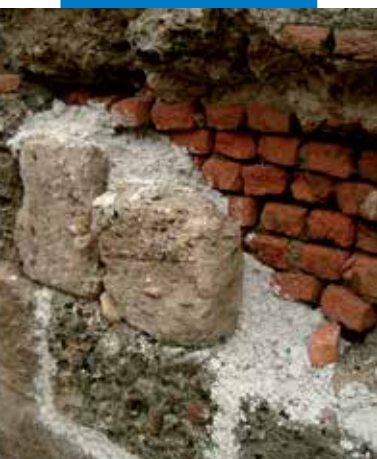
Fal újrabeépítése száritóvakolat habarccsal a helyszínen
