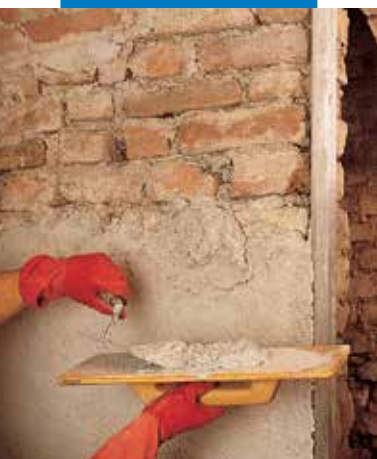
Száritóvakolat bedolgozása a helyszínen
