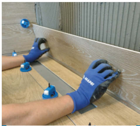
Burkolólapok ragasztása
