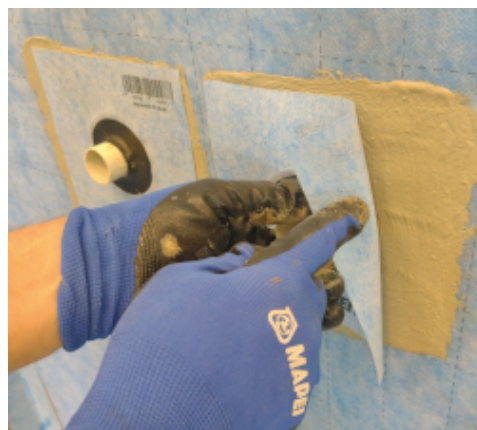
Mapeguard PC elhelyezése
