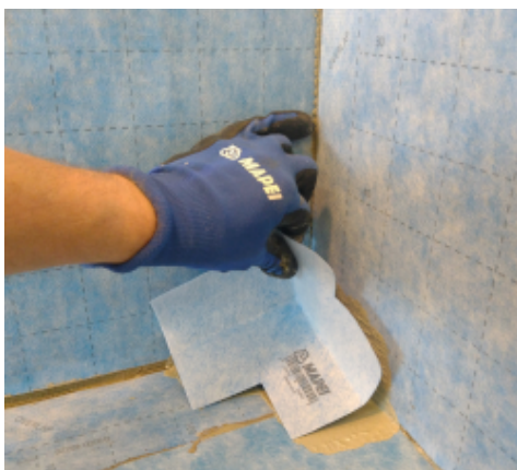
Mapeguard IC elhelyezése
