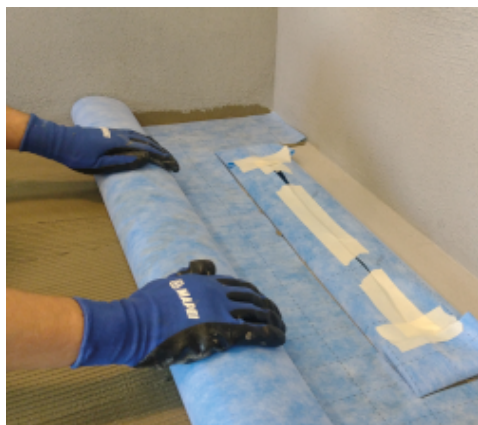
Mapeguard WP 200 elhelyezése
