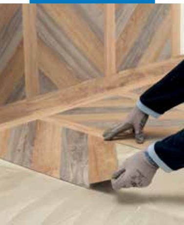
Modul LVT fektetése Ultrabond Eco V4 Evolution-nel
