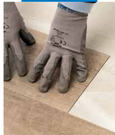
LVT fektetése Ultrabond Eco V4 Evolution-nel
