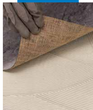
Linóleum fektetése Ultrabond Eco V4 Evolution-nel
