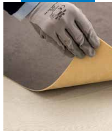
Poliuretán bázisú padlóburkolat fektetése Ultrabond Eco V4 Evolution-nel
