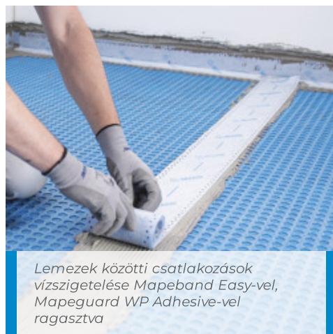
A Mapeguard UM 35 fektetése
