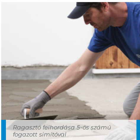
A Mapeguard UM 35 fektetése
