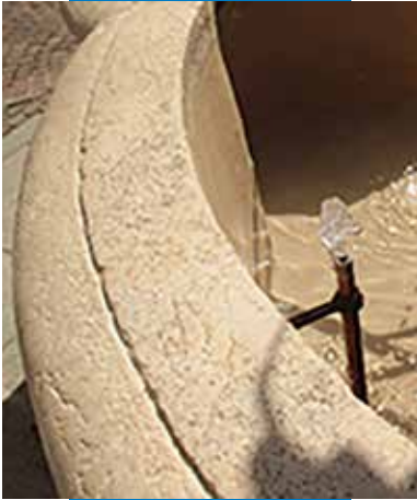
Kő kút medencéjének vízszigetelése
