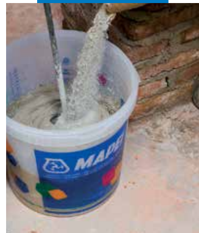
A MapeWall Muratura Fine elkészítése
