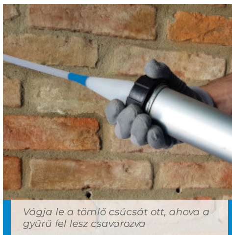
Helyezzen egy kartust a kinyomópisztolyba, majd vágja le a kartus szélét azon az oldalon, ahol a gallér lesz rögzítve
