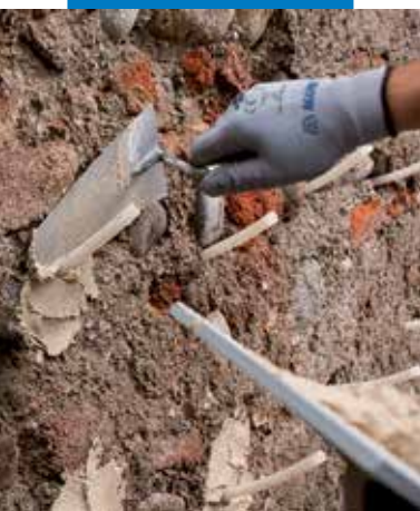
Gumicsövek rögzítése Mape-Antique Allettamentoval
