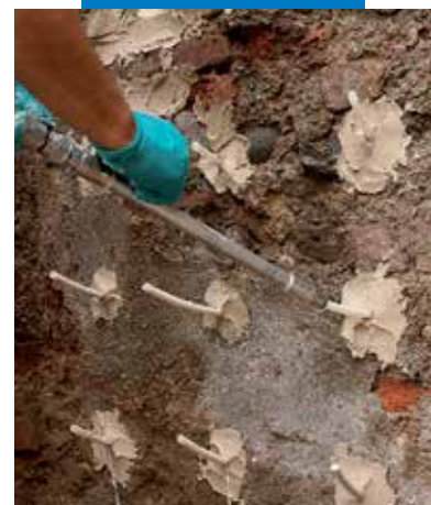
A Mape-Antique I-15 injektálása
