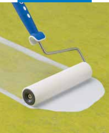
Mapecoat Wet & Dry R11 felhordása linóleum padlóburkolatra
