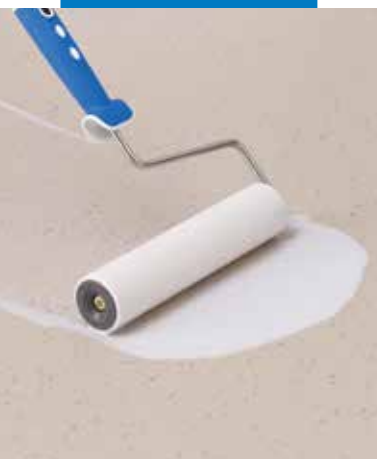
Mapecoat Wet & Dry R11 felhordása homogén PVC padlóburkolatra
