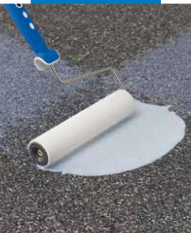
Mapecoat Wet & Dry R11 felhordása PVC padlóburkolatra
