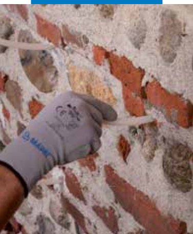
Kis injektáló csövek elhelyezése
