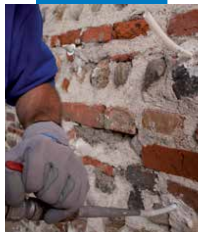
A Mapewall Inietta & Consolida injektálása
