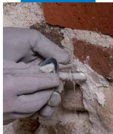
Az injektáló csövek lezárása
