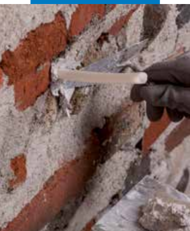
Kis injektáló csövek rögzítése
