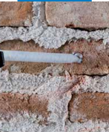
A vegyi dübel bedolgozása
