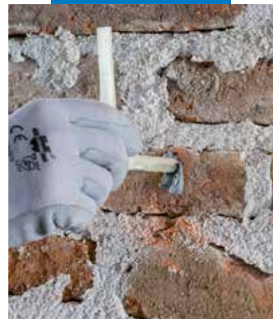
A Mapenet EM Connector beillesztése
