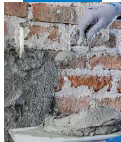
Az első réteg MapeWall Render & Strengthen felhordása
