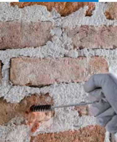
A por eltávolítása a furatokból
