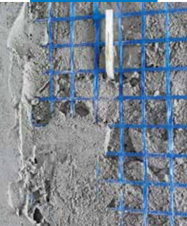
A második réteg MapeWall Render & Strengthen felhordása
