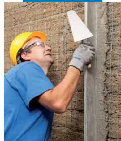
Vezetősávok síkbeliségének ellenőrzése
