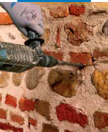
Furatok előkészítése a Mapenet EM Connector számára
