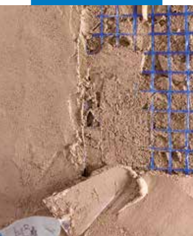
A MapeWall Intonaca & Rinforza második rétegének bedolgozása
