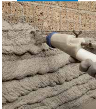
A MapeWall Intonaca & Rinforza bedolgozása vakológéppel
