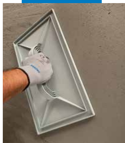
Az aljzat simítása
