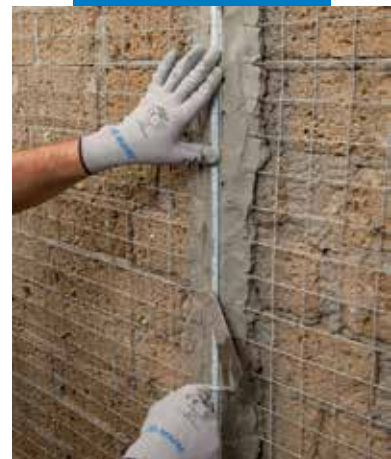
Függőleges vezetősávok elhelyezése
