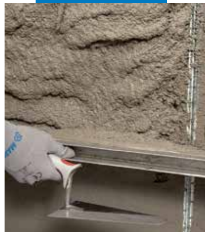
A MapeWall Inject & Consolidate simítása egyenes simítóval
