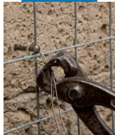
Fém háló megfelelő helyre rögzítése
