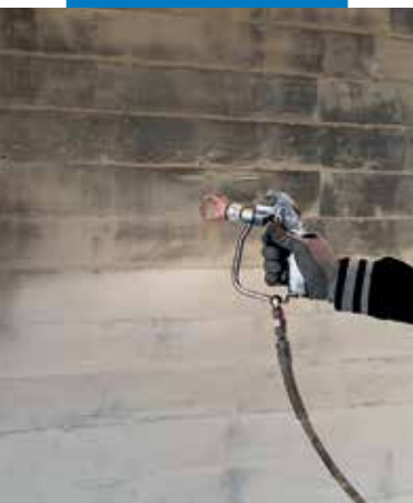
Planiseal WR 85 Gel felhordása airless szórással
