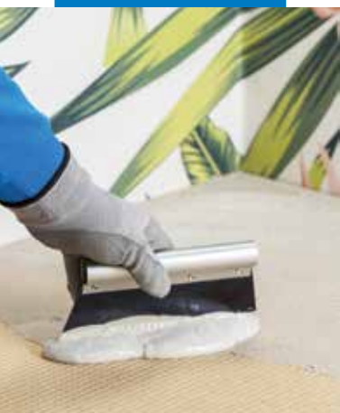
Ultrabond Eco TX3 felhordása hangszigetelő alátétre
