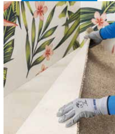
Padlószőnyeg fektetése hangszigetelő alátétre (double stick fektetés)
