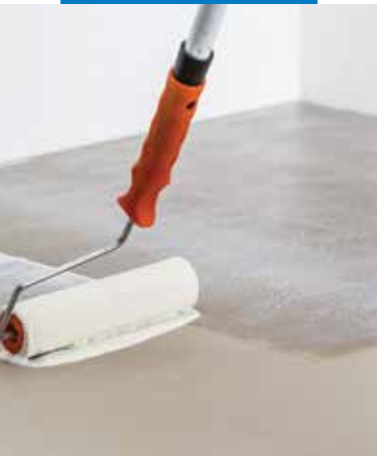
Ultrabond Eco TX3 felhordása hangszigetelő alátét rögzítéséhez
