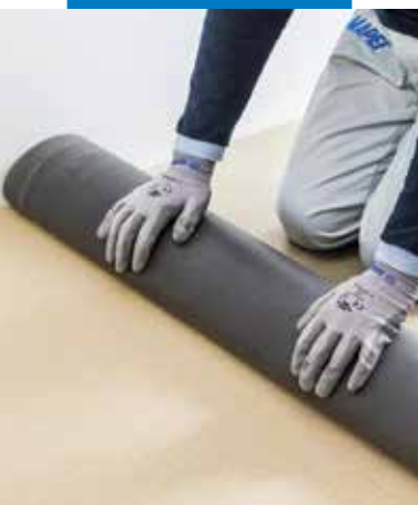
Hangszigetelő alátét fektetése
