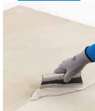
Ultrabond Eco TX3 felhordása aljzatkiegyenlítőre (közvetlen ragasztás)
