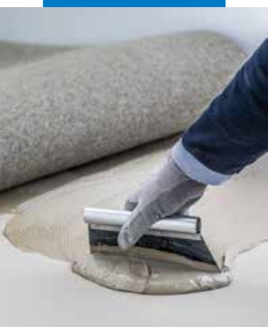
Ultrabond Eco TX3 felhordása filcszőnyeg fektetéséhez
