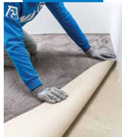
Action Bac® hátoldalú szőnyegpadló fektetése
