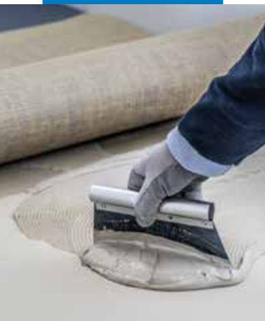
Ultrabond Eco TX3 felhordása linóleum fektetéséhez
