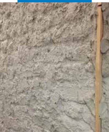
Mape-Antique NHL Eco Rinzafo „zárt pórusú” bedolgozása
