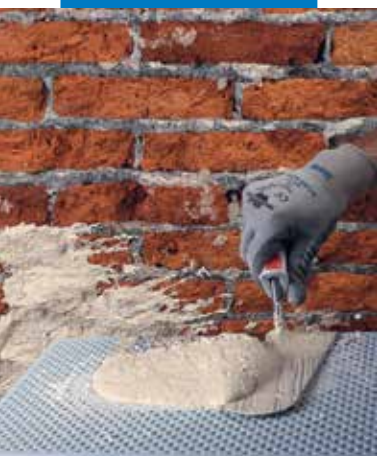
Mape-Antique NHL Eco Rinzafo bedolgozása téglá felületre
