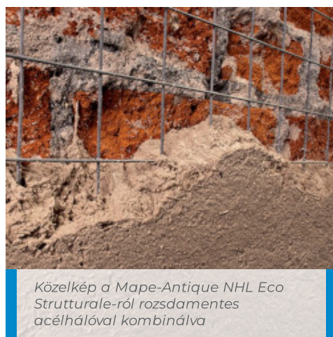
A második réteg Mape-Antique NHL Eco Strutturale felhordása
