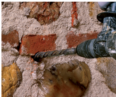
Furatok készítése a Mape-net EM Connector-nak
