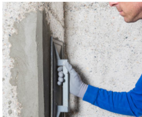
Planitop Rasa & Ripara Zero tömörítése
