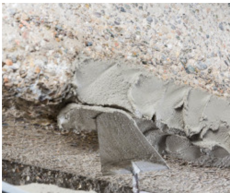
Planitop Rasa & Ripara Zero simítása egyenes lehúzóval
